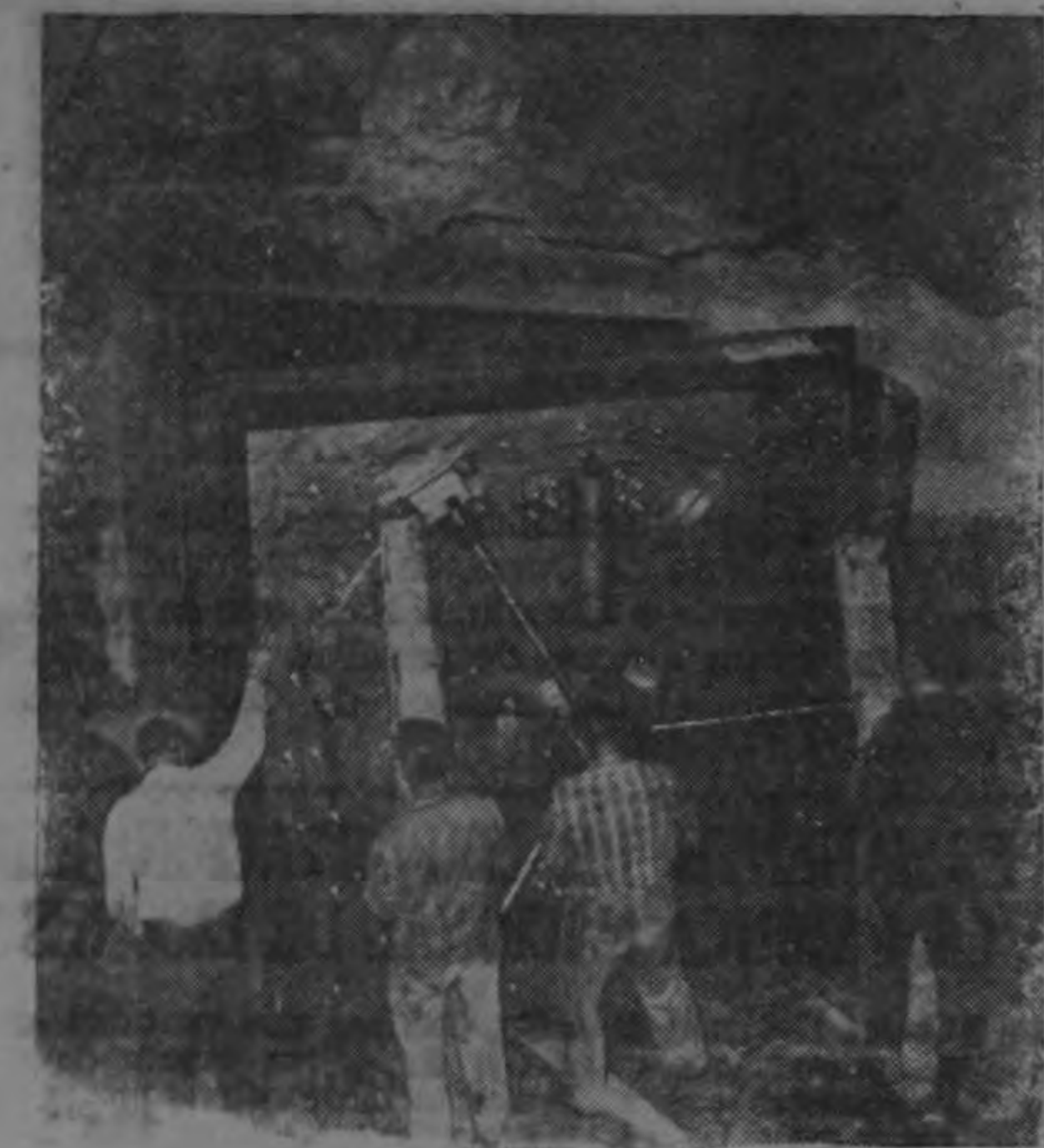
Unos obreros instalan la maciza puerta que cierra la entrada principal de la bóveda
